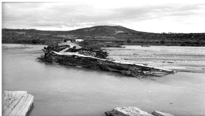
Puente de hierro de las Pilas (Estadilla) después de haber sido dinamitado por los republicanos (marzo de 1938). (AHPH)
