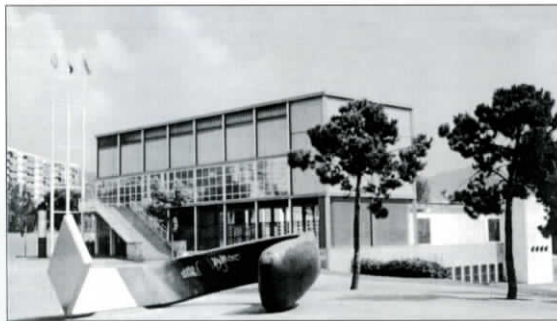
Reconstrucción del Pabellón Español de la Exposición Internacional de París de 1937. Av. Cardenal Vidal i Barraquer s/n (1992)
