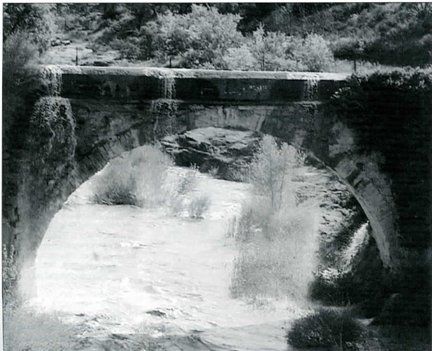
Río Vero. Acueducto de Las Canales. Documentada su construcción en el siglo XVI. Un airoso arco de medio punto permite que el agua del salto de Pozán llegue a Barbastro
